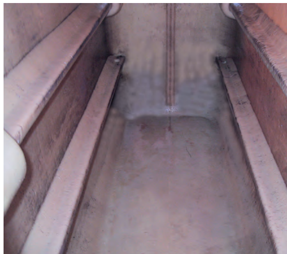
Der saubere Tank nach der Innenreinigung
